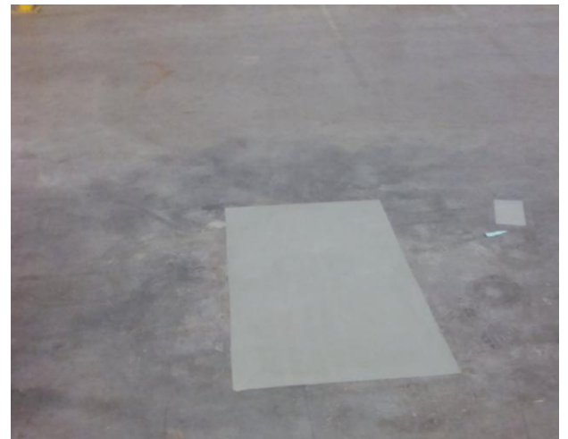
Fotografia 17. Naprawa odspojenia poprzez lokalną wymianę wierzchniej warstwy.
