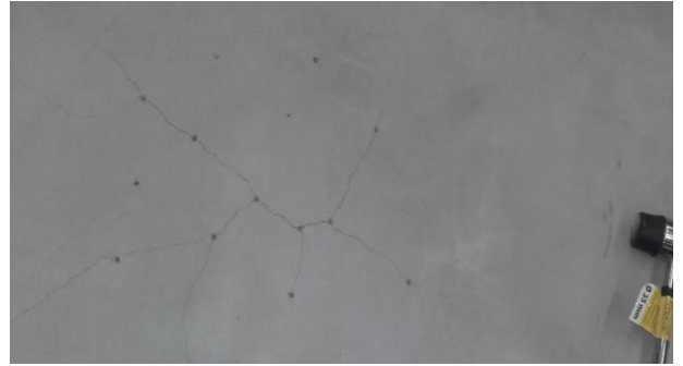
Fotografia 16. Naprawa odspojenia poprzez wstrzyknięcie masy żywicznej.
