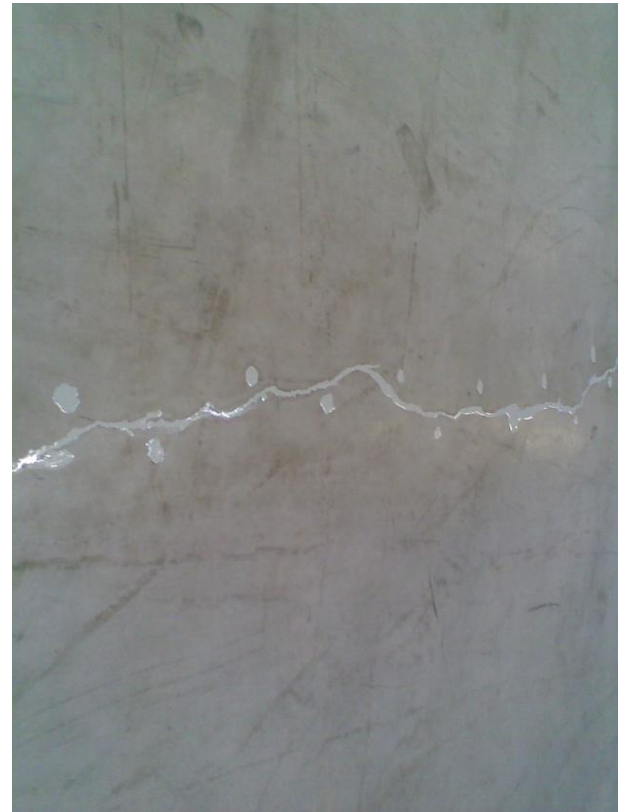
Fotografia 10. Naprawa pęknięcia posadzki poprzez zastosowanie zszycia prętami
