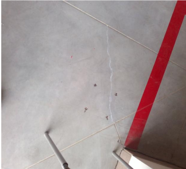
Fotografia 19. Przykład naprawy zarysowania bez fazowania za pomocą masy dylatacyjnej.
