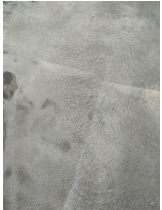
Fotografia 12. Ślady pozostawione przez kruszywo, które dostało się pod łopatkę zacieraczki.
