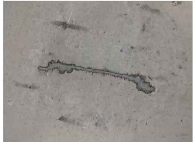
Fotografia 21. Przykład naprawy ubytku po wystającym włóknie stalowym poprzez uzupełnienie masą żywiczną.
