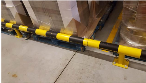
Fotografia 3. Osadzenie odbojników umożliwiających swobodną pracę pól posadzkowych
