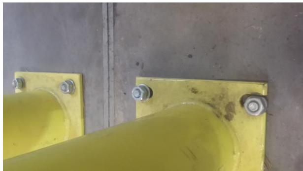
Fotografia 4. Osadzenie odbojników umożliwiających swobodną pracę pól posadzkowych
