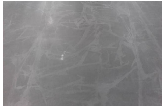
Fotografia 6. Ślady po folii okryciowej.
