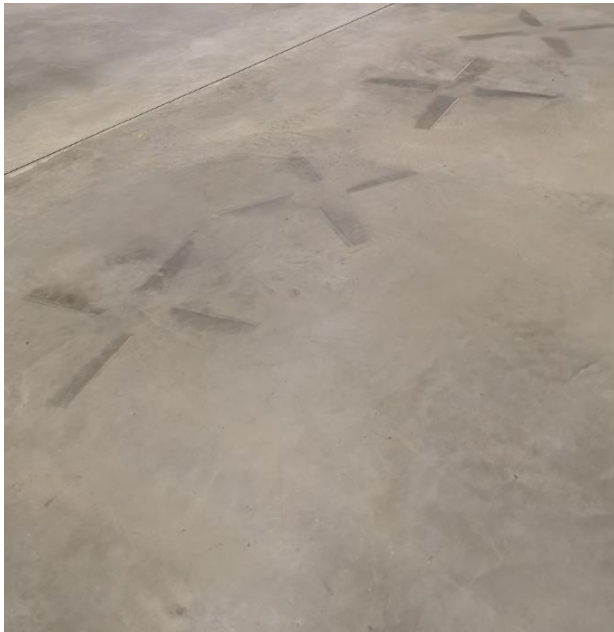
Fotografia 14. Ślad odbicia łopatek maszyn zacierających.
