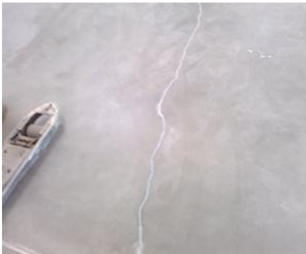
Fotografia 20. Przykład naprawy zarysowania z fazowaniem i uzupełnieniem masą naprawczą.
