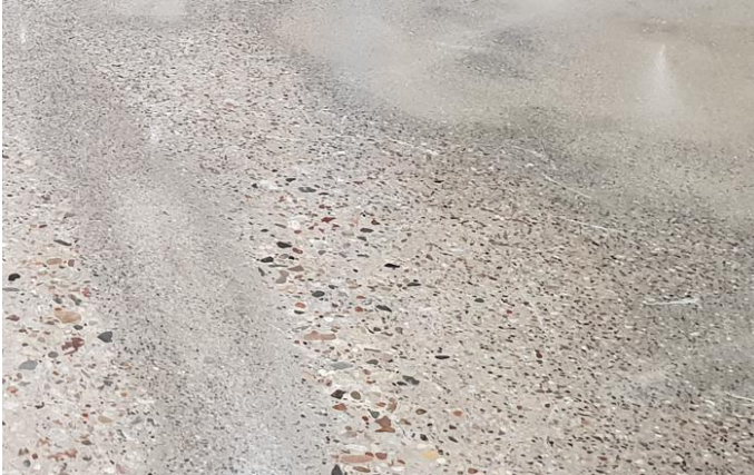
Fotografia 10-1. Przykład efektu lastrico po szlifowaniu powierzchni posadzki.
