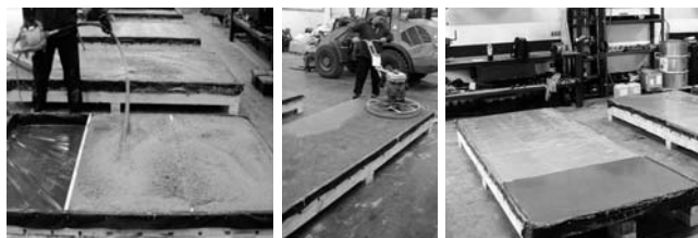
Wykonywanie posadzki w warunkach przemysłowych
