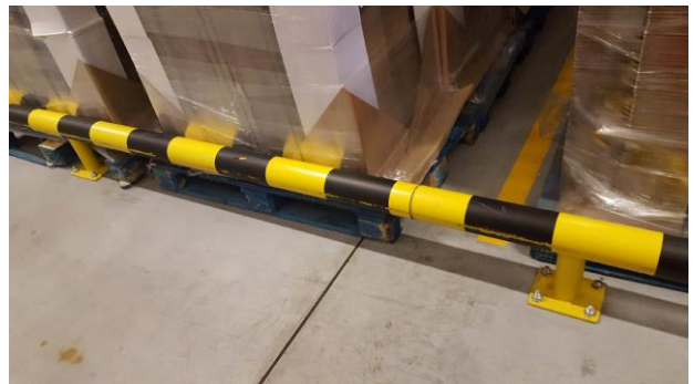
Rys 1. Niewłaściwe osadzenie odbojników powodujące zszycie pól posadzkowych
