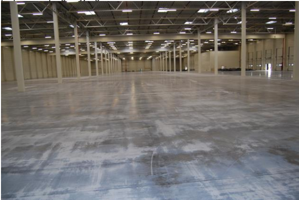
Rys. 4 Wykwyty solne posadzki w okresie dojrzewania posadzki przed rozpoczęciem eksploatacji.
