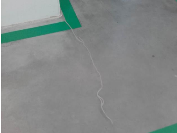
Rys. 7 Zarysowanie przysłupowe.
