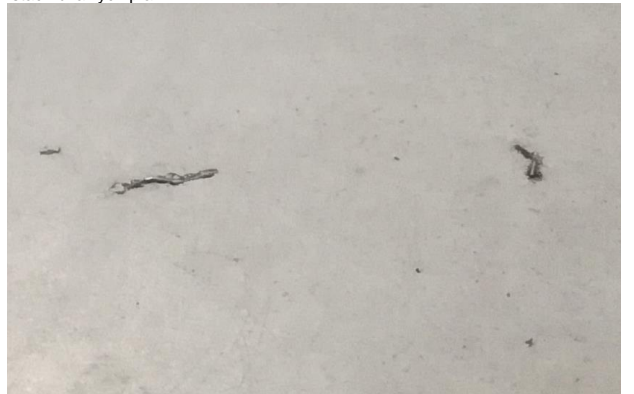
Rys. 9 Ślady po włóknach stanowych na posadzce.
