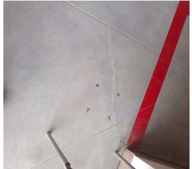
Rys. 13 przykład naprawy zarysowania bez fazowania za pomocą masy dylatacyjnej.
