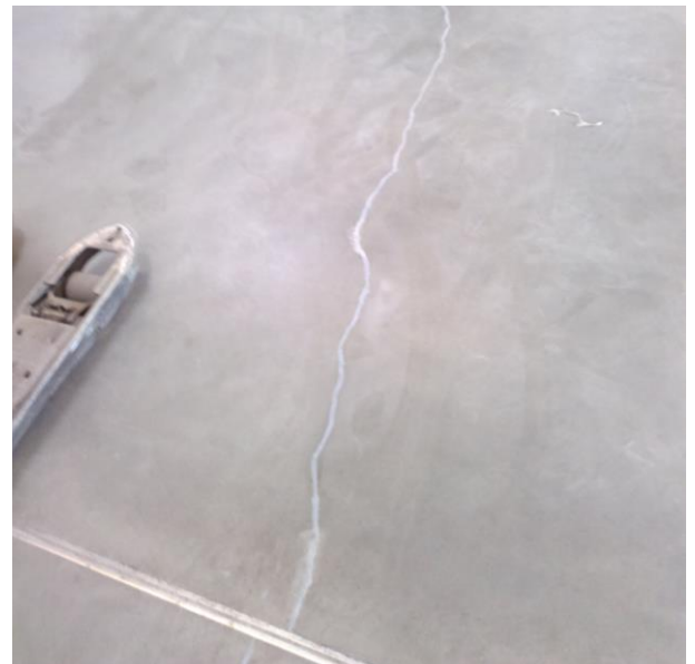
Rys. 14 przykład naprawy zarysowania z fazowaniem i uzupełnieniem masą żywiczną.
