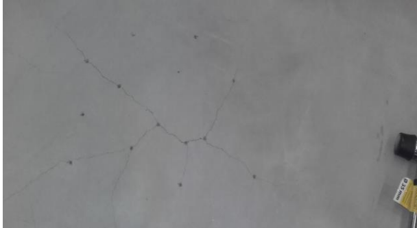
Rys. 10 Naprawa odspojenia poprzez wstrzyknięcie masy żywicznej.
