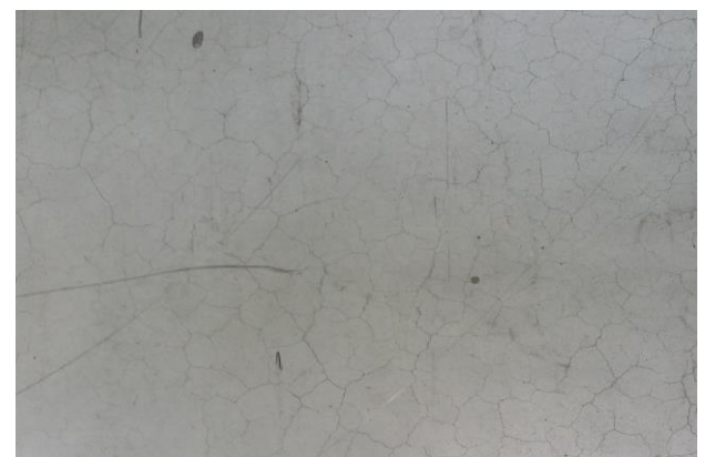
Rys. 5 - 6 Przykład mikrospekkań tzw. sieci pajęcznej na posadzce .
