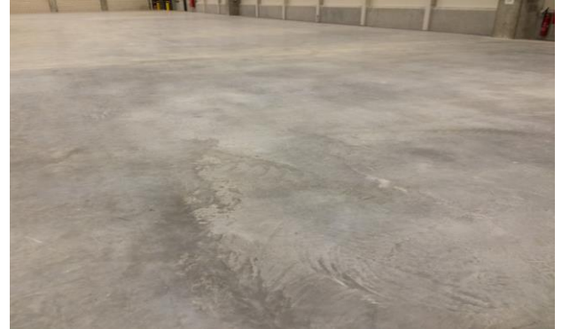
Rys. 8 przebarwienie – blizna na powierzchni posadzki.
