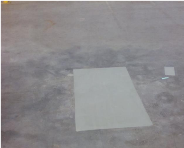
Rys. 11 Naprawa odspojenia poprzez lokalną wymianę wierzchniej warstwy.
