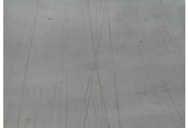
Rys. 12 przykład uszkodzeń mechanicznych posadzki – zarysowania od np. przesuwania palet bez prawidłowego podnoszenia.
