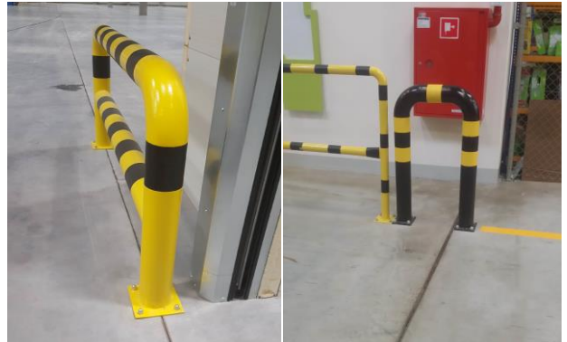
Rys 1. Niewłaściwe osadzenie odbojników powodujące zszycie pól posadzkowych
