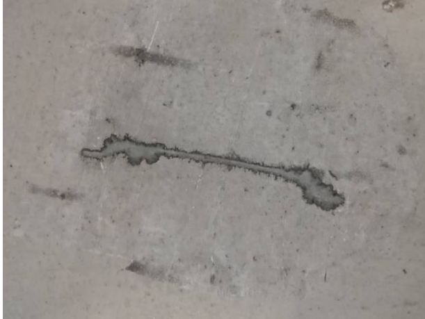
Rys. 15 przykład naprawy ubytku po wystającym włóknie stalowym z uzupełnieniem masą żywiczną.
