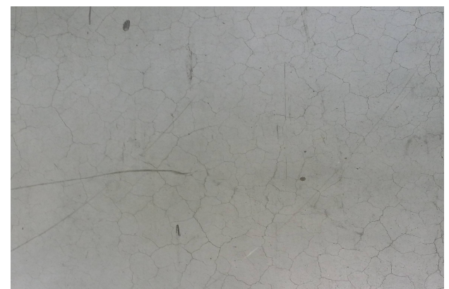
Rys. 5- 6 Przykład mikrospeków tzw. sieci pajęcznej na posadzce .
