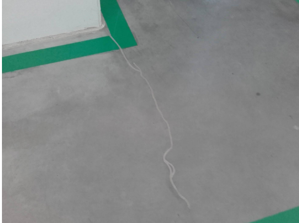
Rys. 7 Zarysowanie przysłupowe.
