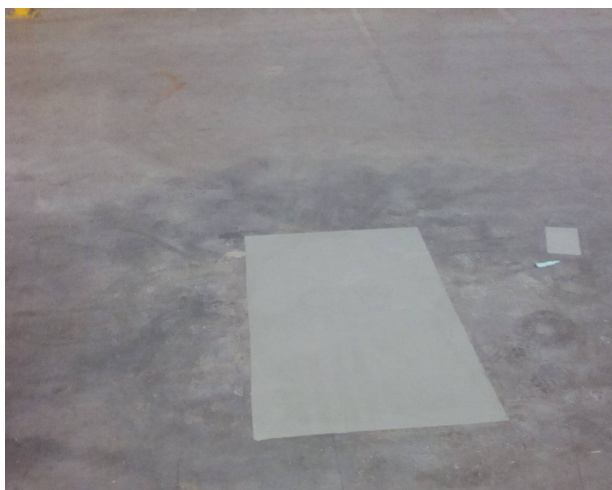
Rys. 11 Naprawa odspojenia poprzez lokalną wymianę wierzchniej warstwy.
