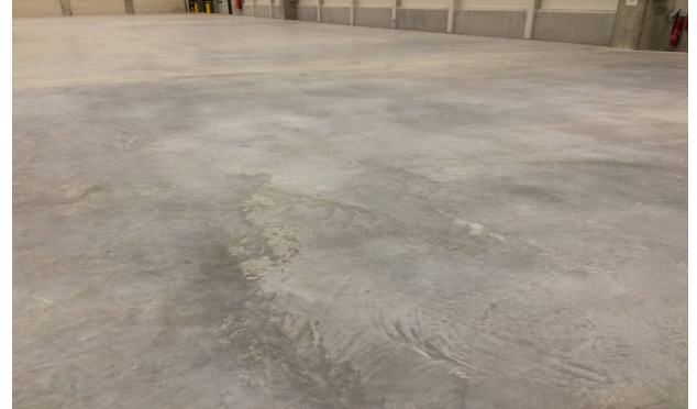
Rys. 8.1 przebarwienie – blizna na powierzchni posadzki.
