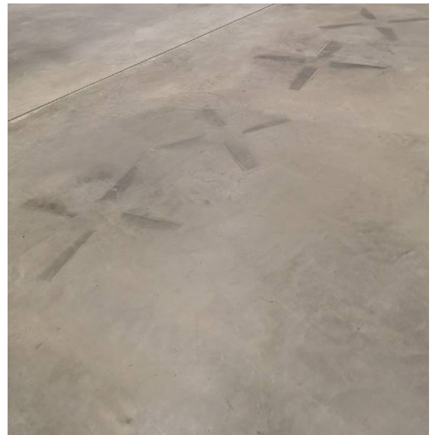
Rys. 8.2 ślad odbicia na powierzchni posadzki łopatek zacieraczek.
