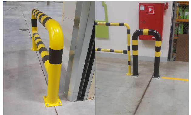
Rys 1. Niewłaściwe osadzenie odbojników powodujące zszycie pól posadzkowych
