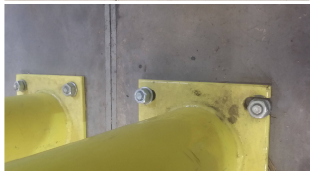
Rys. 2 i 3 Osadzenie odbojników umożliwiających swobodną pracę pól posadzkowych – propozycja rozwiązań.
