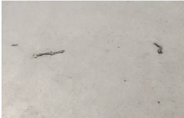
Rys. 9 Ślady po włóknach stanowych na posadzce.
