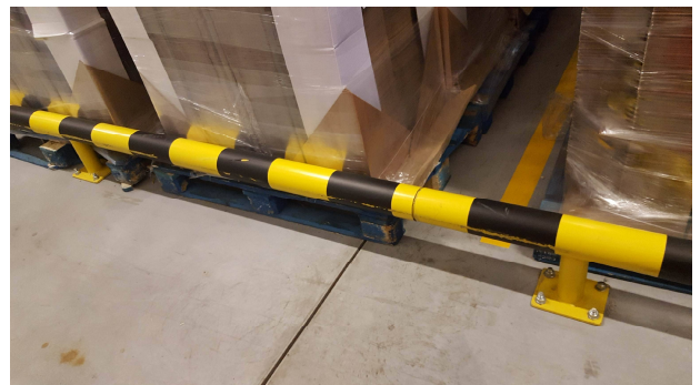
Rys 1. Niewłaściwe osadzenie odbojników powodujące zszycie pól posadzkowych
