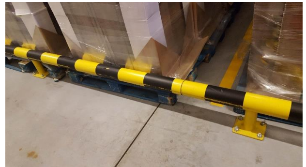
Abb. 1. Falsche Montage von Abweisern (Schutzpfosten), die das „Zusammennähen“ von Bodenfeldern verursacht.
