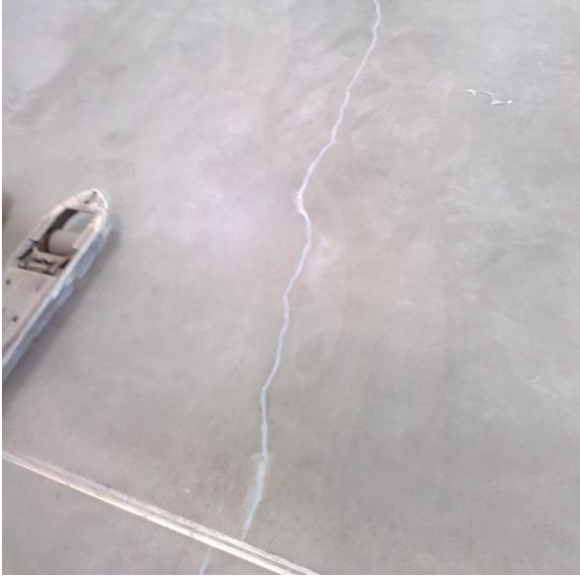
Abb. 14. Ein Beispiel für die Reparatur von Kratzern mit Abschrägung und Ergänzung mit Harzmasse.
