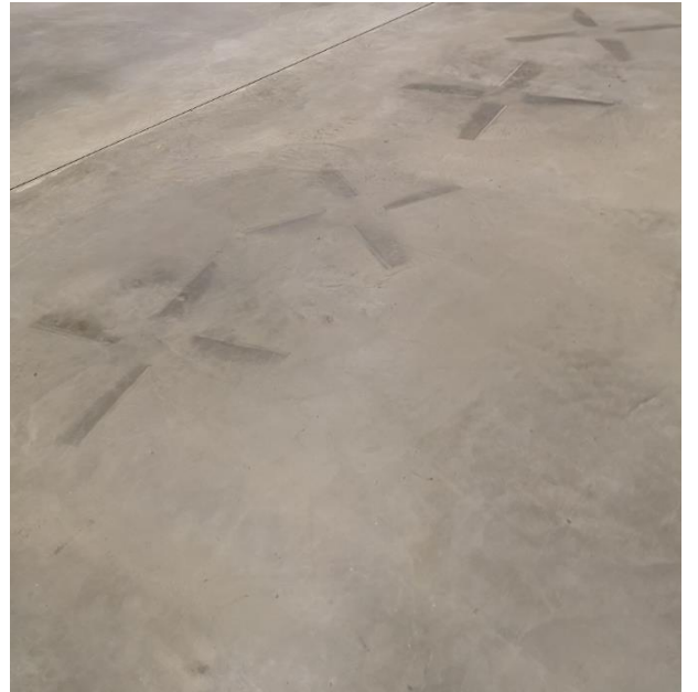
Abb. 8.2. Spur des Abbilds der Flügelglätter auf dem Boden
