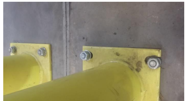
Abb. 2 u. 3. Richtige Installation von Schutzpfosten, die eine freie Arbeit von Bodenfeldern ermöglicht – Lösungsvorschlag.
