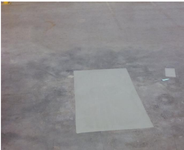
Abb. 11. Reparatur der Ablösung durch lokalen Austausch der obersten Schicht
