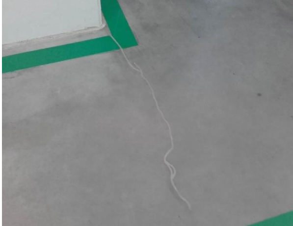
Abb. 7. Risse in der Pfeilergegend
