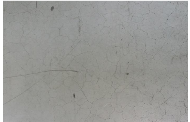
Abb. 5 – 6. Ein Beispiel von Mikrorissen, sog. Spinnennetz auf dem Boden
