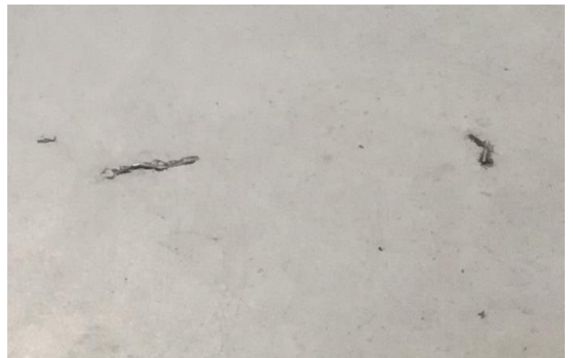
Abb. 9. Spuren von Stahlfasern auf dem Boden
