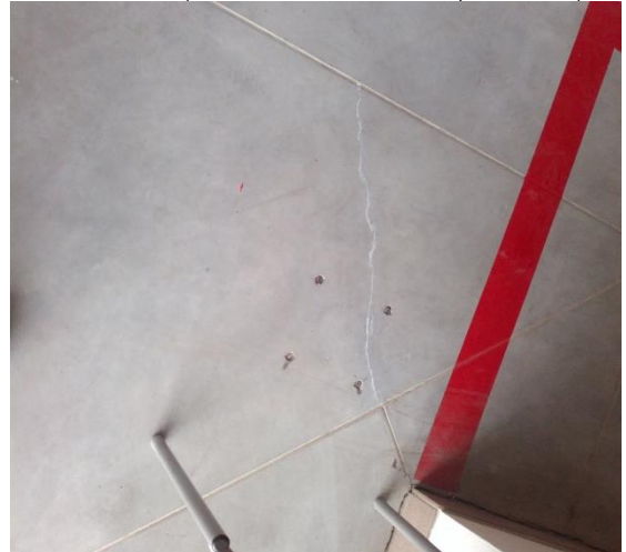
Abb. 13. Ein Beispiel für die Reparatur eines Kratzers ohne Abschragung mit einer Fugenmasse
