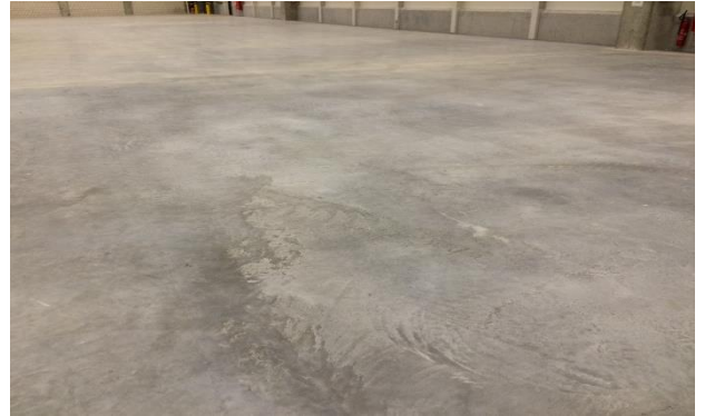
Abb. 8.1. Eine Verfärbung - Narbe auf der Oberfläche des Bodens
