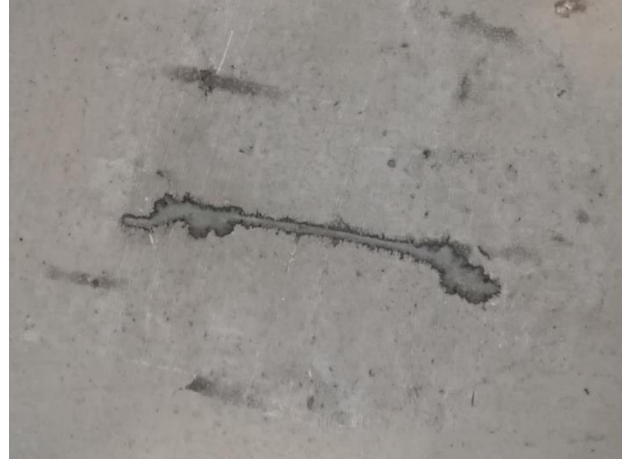
Abb. 15. Ein Beispiel für die Reparatur eines Mangels (Lochs) nach einer vorstehenden Stahlfaser unter Auffüllung der Harzmasse.
