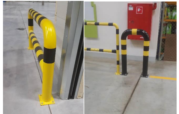
Abb. 1. Falsche Montage von Abweisern (Schutzpfosten), die das „Zusammennähen“ von Bodenfeldern verursacht.
