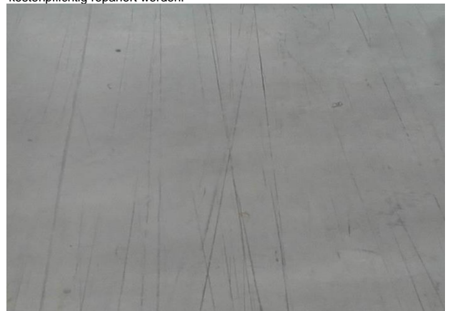
Abb. 12. Beispiel für mechanische Beschädigung des Bodens – Kratzer z.B. aufgrund des Verschiebens von Paletten, ohne sie zu heben.
