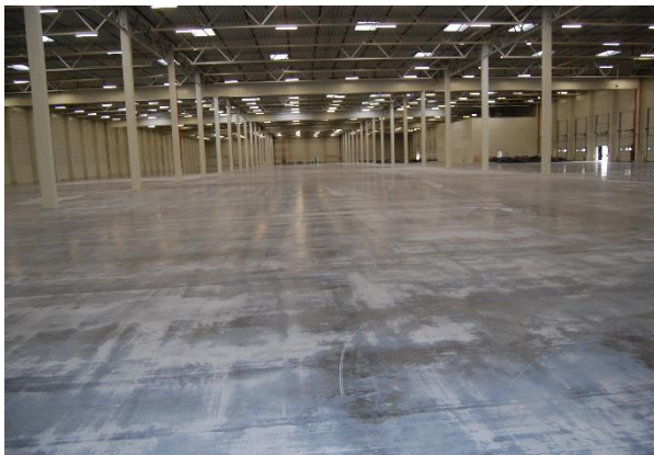
Abb. 4. Salzausblühungen auf dem Boden während der Reifung des Bodens vor Betriebsbeginn.
